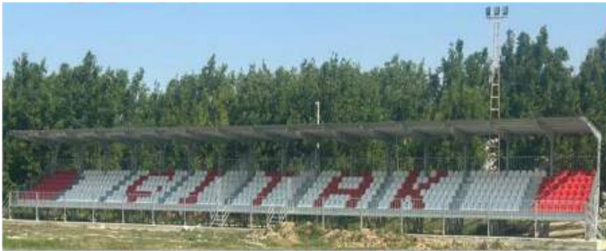
İhale kapsamında Çıtak Mahallesi futbol sahası tribünü
