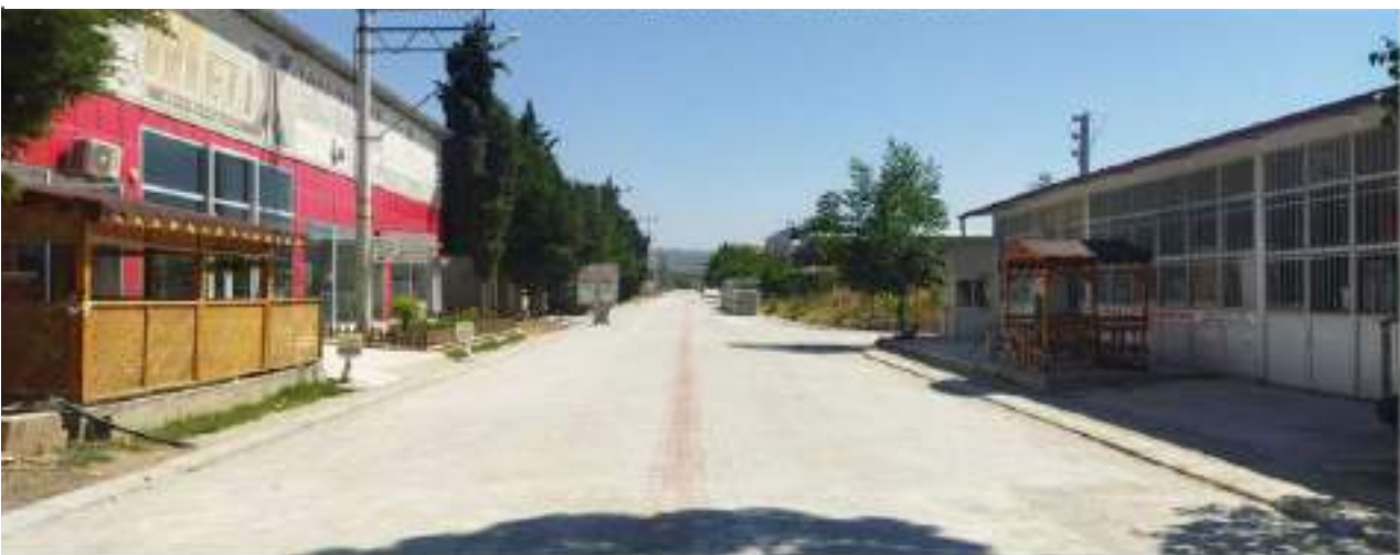
Yeşil Çivril Sanayi Sitesi Yollarının Beton Parke ile Düzenleme Yapılması
