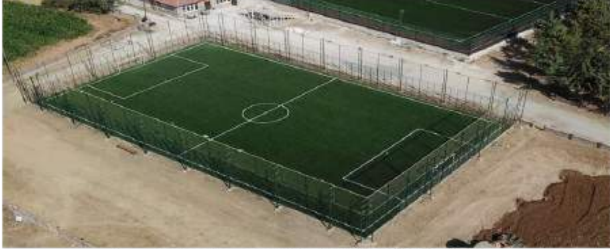
Gürpınar Mahallesi Sentetik Çim YüzeYLİ Sahanın halısının deęiştirilmesi
