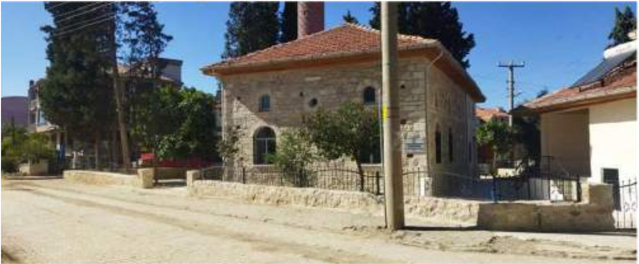
Hamam Önü Cami Restorasyon Çalışmaları
