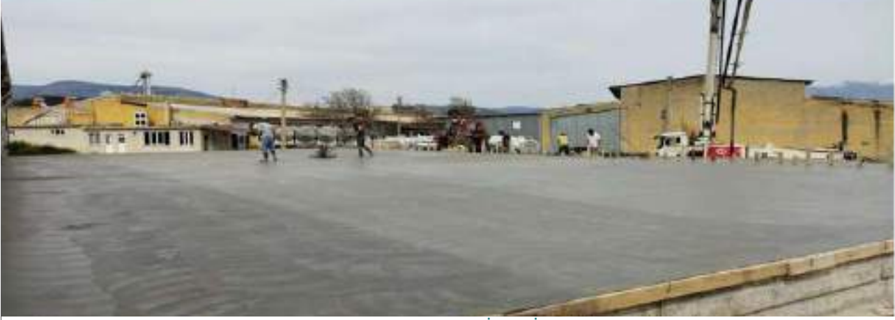
Yeşil Çivril Sanayi Sitesi İlave İşyeri Yapımı
