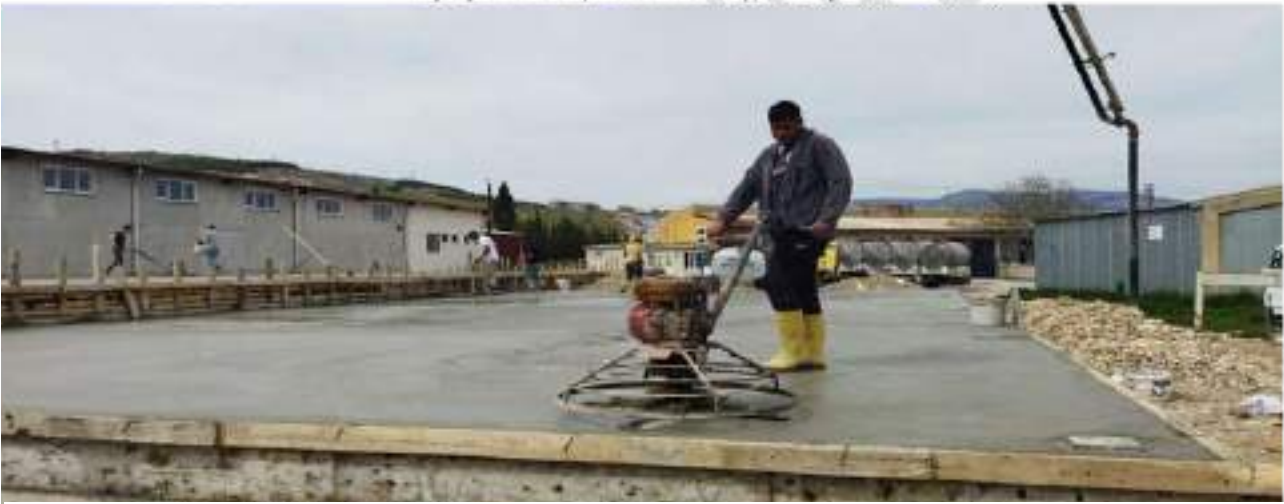
Yeşil Çivril Sanayi Sitesi İlave İşyeri Yapımı
