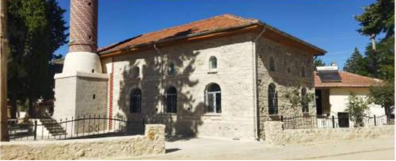
Hamam Önü Cami Restorasyon Çalışmaları
