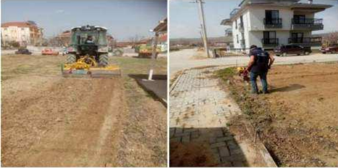
1038 no lu sokakta bulunan parka çim ekimi yapmak için çapa ve tesviye işlemi yapıldı.
