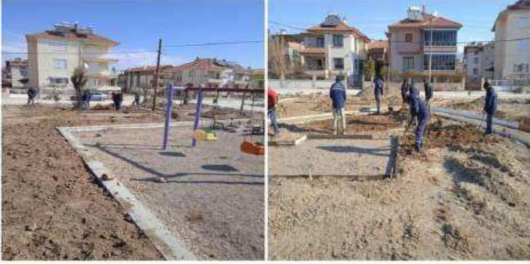
Çayır mahallesinde yeni yapılan parkın çim ekimi için toprak düzenleme çalışmaları.
